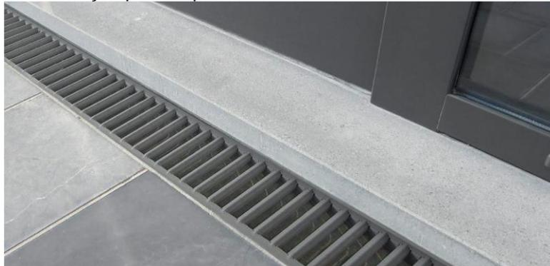
Figura: Grelha de ferro fundido.
